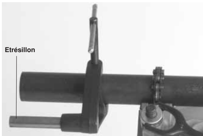
Figure 4 – Utilisation de l'étrésillon n° 691 lors du filetage des tuyaux Ø 3/4 po ou plus
